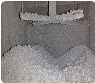
Die Abreinigung von Abscheidefläche und Elektrode erfolgt automatisch durch Vibration. Der Feinstaub fällt in den Auffangbehälter. In den meisten Fällen genügt die Leerung alle drei bis vier Wochen.
