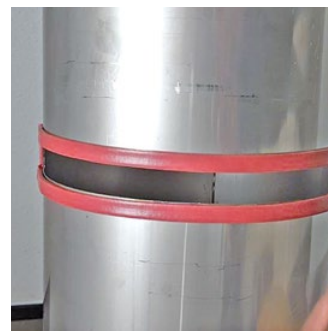
2. Die Einbauöffnung mit Hochtemperaturdichtung versehen
