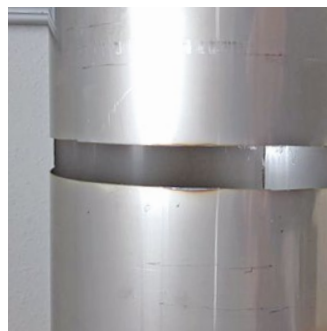
1. Die Halbschale mit dem Schlitz dient zur markierung der Einbauöffnung an ein vorhandenes Abgassystem Einbauöffnung mit Trennscheibe ausschneiden
