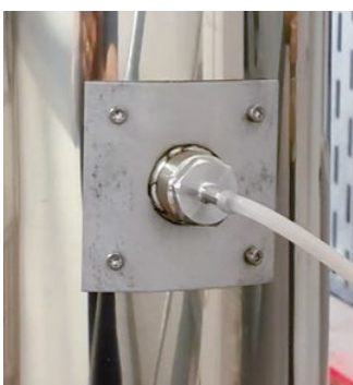
7. Anschluss-Stutzen für Unterdruckschlauch anbringen
