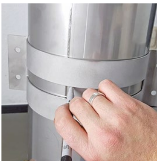
1. Die Halbschale mit dem Schlitz dient zur markierung der Einbauöffnung an ein vorhandenes Abgassystem Einbauöffnung mit Trennscheibe ausschneiden
