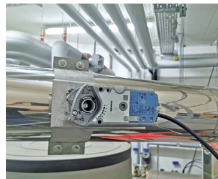
6. Stellantrieb auf Halblettelplatte und Welle aufsetzen
